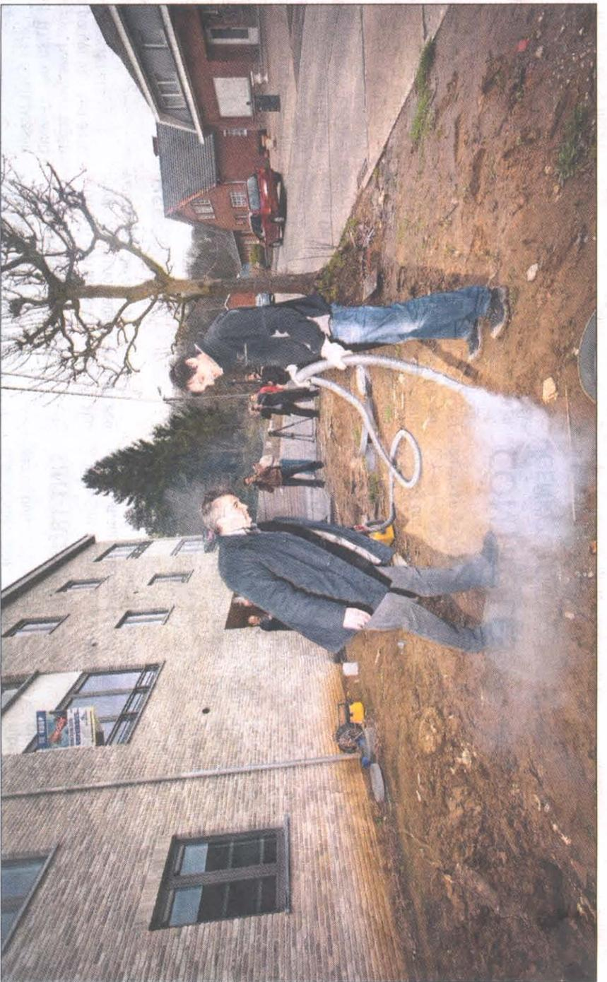
**Met rook wordt getest of alle afvoerbui-zen juist zijn aan- gesloten. Hier is dat niet het geval en moet de aannemer de sleuven opnieuw open gra-ven.**
