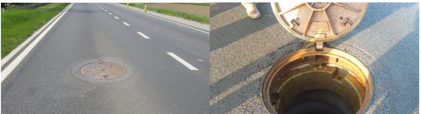
Eindresultaat van plaatsing deksels met zwevende dekplaat.
