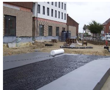
Ondergrondse Infiltratie-units
