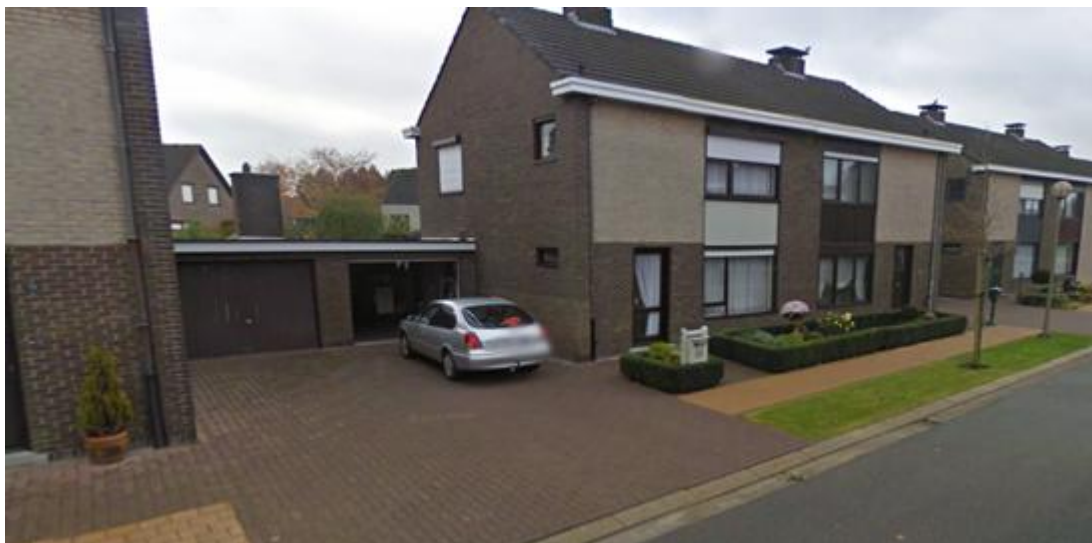
Figuur 1.7: indien men een gesloten bebouwing heeft waarbij een zijmuur beschikbaar is om de achterste dakhelft gravitair af te koppelen geldt de uitzondering niet omdat men niet moet breken onder of door de woning om de afkoppeling te bekomen!
